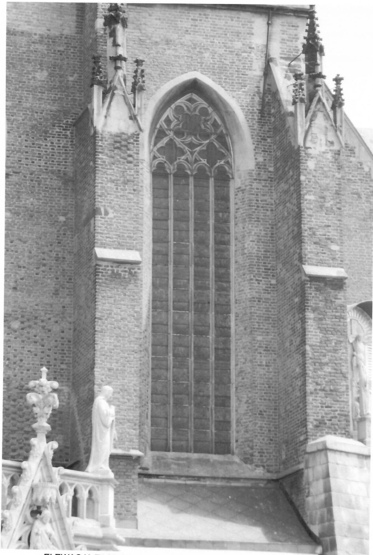
ELEWACJA ZACHODNIA, OKNO OD STRONY NAROZNIKA POŁUDNIOWEGO
