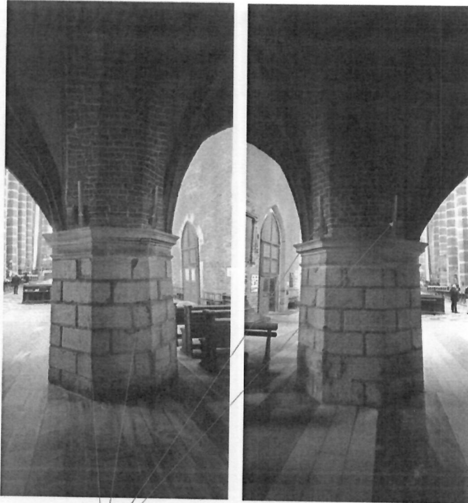
Miejsca montażu kolumn głośnikowych
